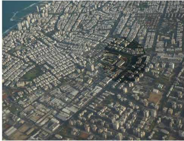
Vista aerea del progetto completato
